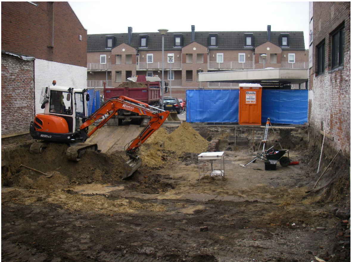
Afbeelding 1.2 Aanleg van het vlak met behulp van de minikraan.
